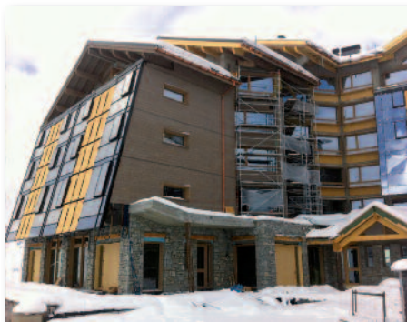
Hôtel en construction / Val Thorens (73) / SERAG
